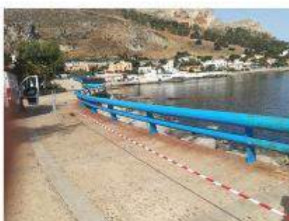
Foto tubolari ultimati
