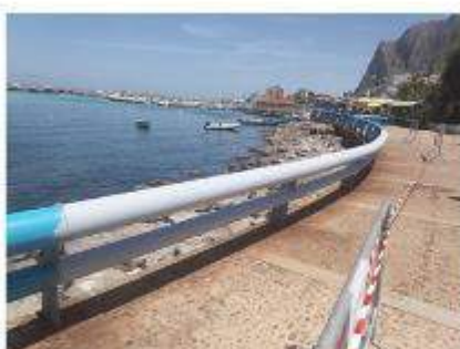
Foto trattamento preliminare tubolari con prodotto Zincofond
