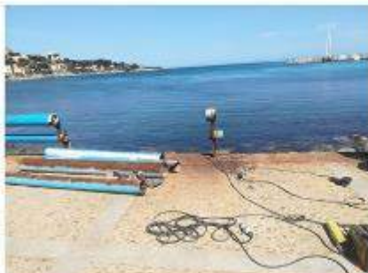
Foto rimozione tubolari ammalorati
